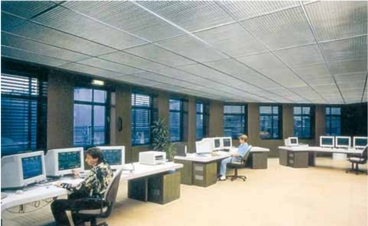
Schaltwerk einer Raffinerie
